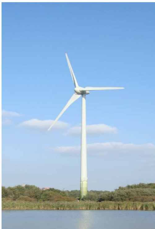
Afbeelding 10 - de turbines van het project Kilwind zijn van het type Enercon E70, masthoogte 85m. Referentie hiervoor is De Amstelvogel in Oudekerk aan de Amstel, alleen dan zonder het groene verloop aan de onderkant van de mast
