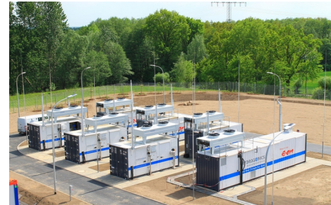
PtG installatie in Falkenhagen, 360 Nm 3 H 2 /uur
